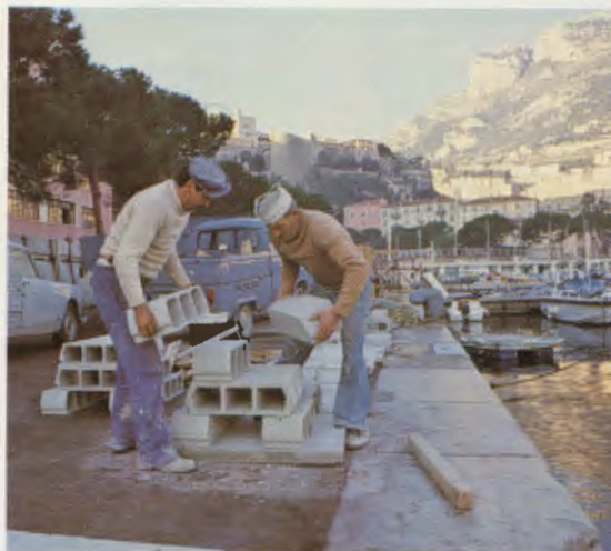
Construction d'un récif alvéolaire de 500 Kg.
