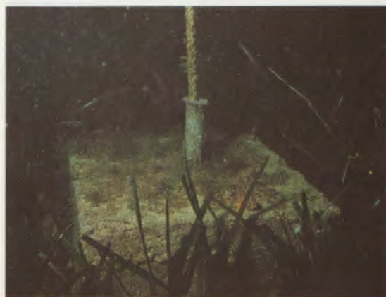
Corps mort d'ancrage des balises de surface.
