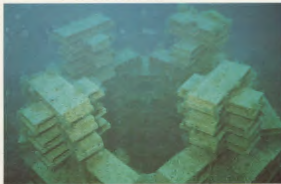
Récif artificiel octogonal 6 mois après l'immersion à 14 mètres
